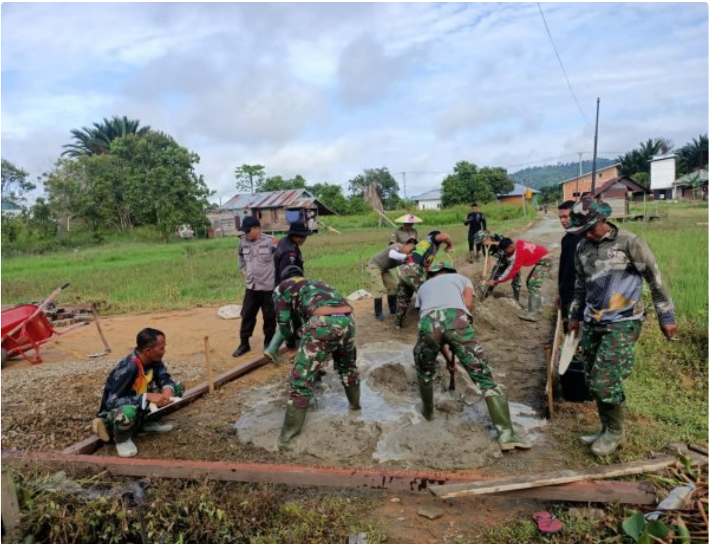
Kompak, Satgas TMMD ke- 118 Bareng Warga Semenisasi Jalan di Desa Malinau Sebrang
